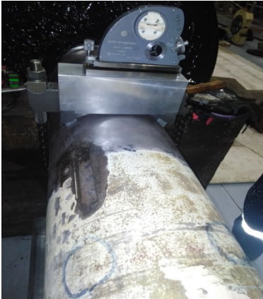
Nivelando la base ...
