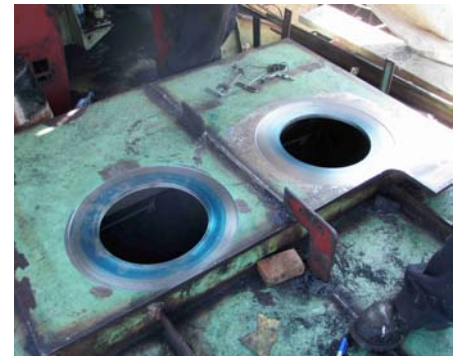
Ambos asientos controlados Fuente: P3140520.JPG
